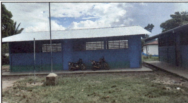
Instalación completa del techo de un edificio de dos aulas
