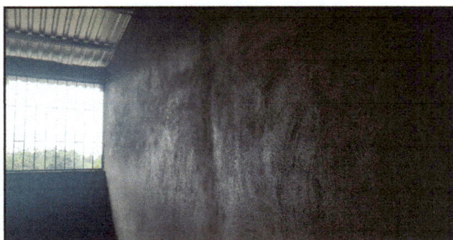
Reparación de las paredes de un aula.
