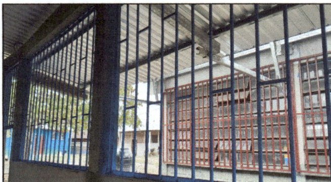
Instalación de balcones de un aula.
